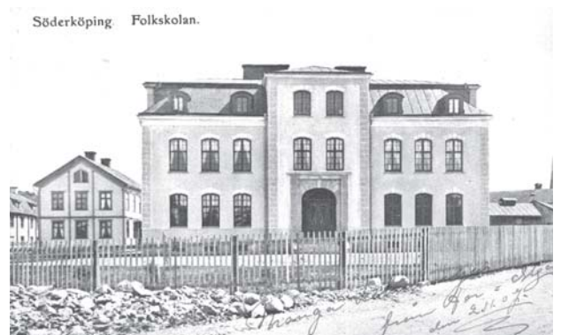
Skolbyggnaden till vänster byggdes 1856. Följdes 1905 av stora Folkskolebyggnaden på bilden.
