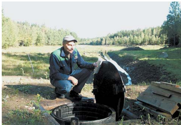
Johan Bergström vid den "munk" som skall reglera vattennivån i den nya sjö om ca 4 hektar som sedan upptar hela den öppna delen av miljön bortom Johan. Djupet i sjön blir som mest 4 meter.
