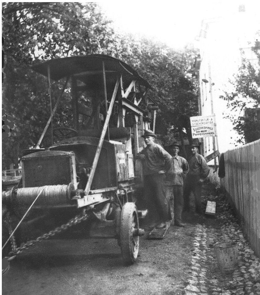
Till vänster syns en arbetsmaskin, som användes på 20-talet när vatten- och avloppsledningar drogs i Söderköping. Bilden är tagen på Åpromenaden intill bokhandeln, som skylten visar.
