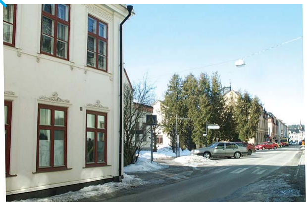
Bild 2 Det här gamla ståtliga huset har funnits här länge. Inne på gården kan man finna två uthus som troligen är lika gamla. På 1920-talet fanns här flera andra hus längs utmed gatan. Se på kartbilden. De tillhör tiden före det nuvarande huset, vilket byggdes längre in på tomten. "Hyddans" tomt är på kartan ännu obebyggd.
