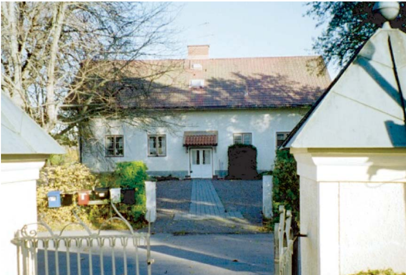
Det vita stora huset intill Skällviks kyrka var en gång en skola. Bilden är tagen från kyrkogården. På övervån till vänster var det småskola (klass 1-2) och lärarinnan bodde på övervåningens högra sida.
