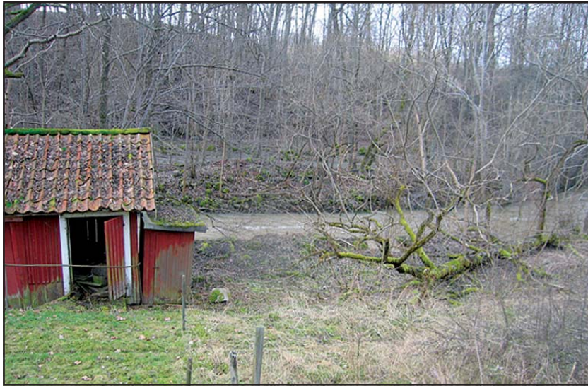
ca 50 meter nedströms Viggeby Kamla Kraftstation låg här Gamla Stro Kvarn. På hitsidan strömfåran kan man ännu se rester av kvarnbyggnadens fundament.
