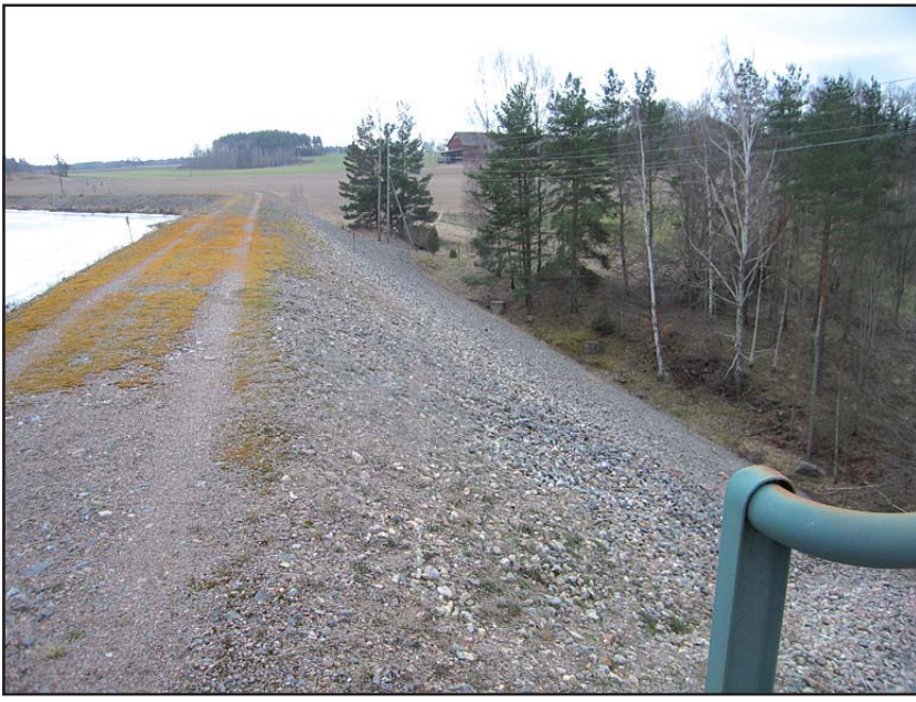
Fördämningen sedd från kraftverket. Det är ganska stor höjdskillnad från vattenståndet i dammen till vattnet som kommer ur kraftverket . Ca 16 meters fallhöjd.
