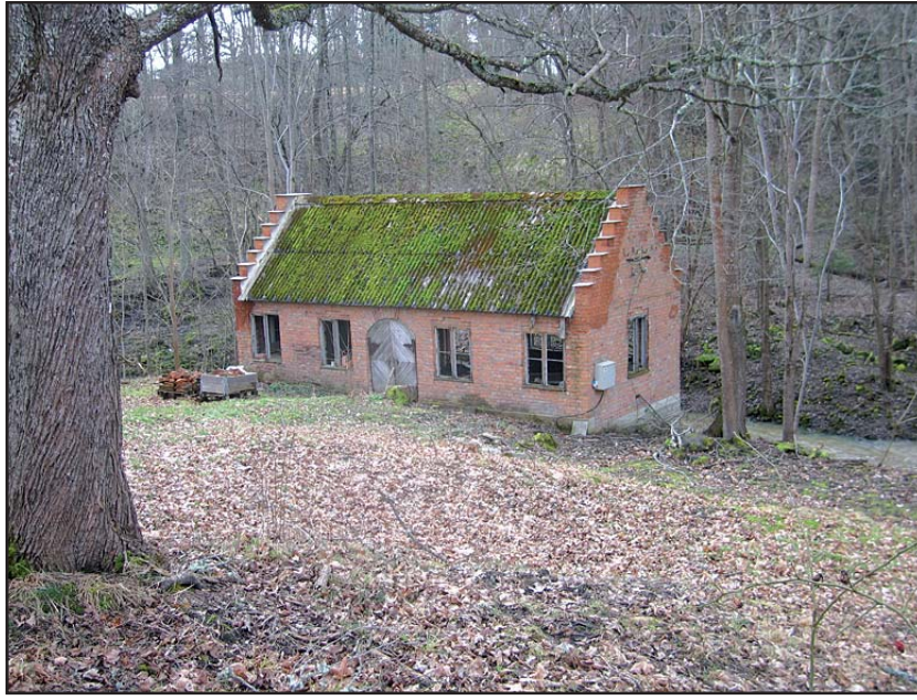
Detta är vad som återstår av Viggeby gamla kraftstation. En vacker byggnad - men förfallen.
