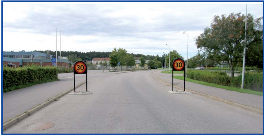
De här skyltarna finner man på Ringvägen, strax väster om "rondellen" vid Fix-området. Bilar kan inte mötas. Och före "rondellen" finns vägbulor.
