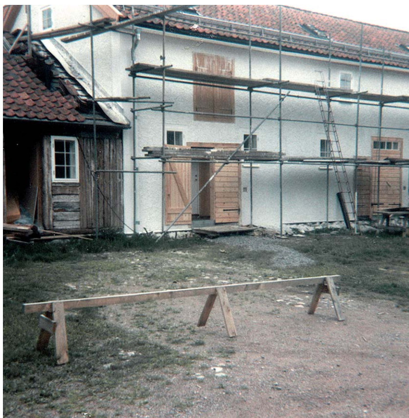
Ett gårdshus under renovering
