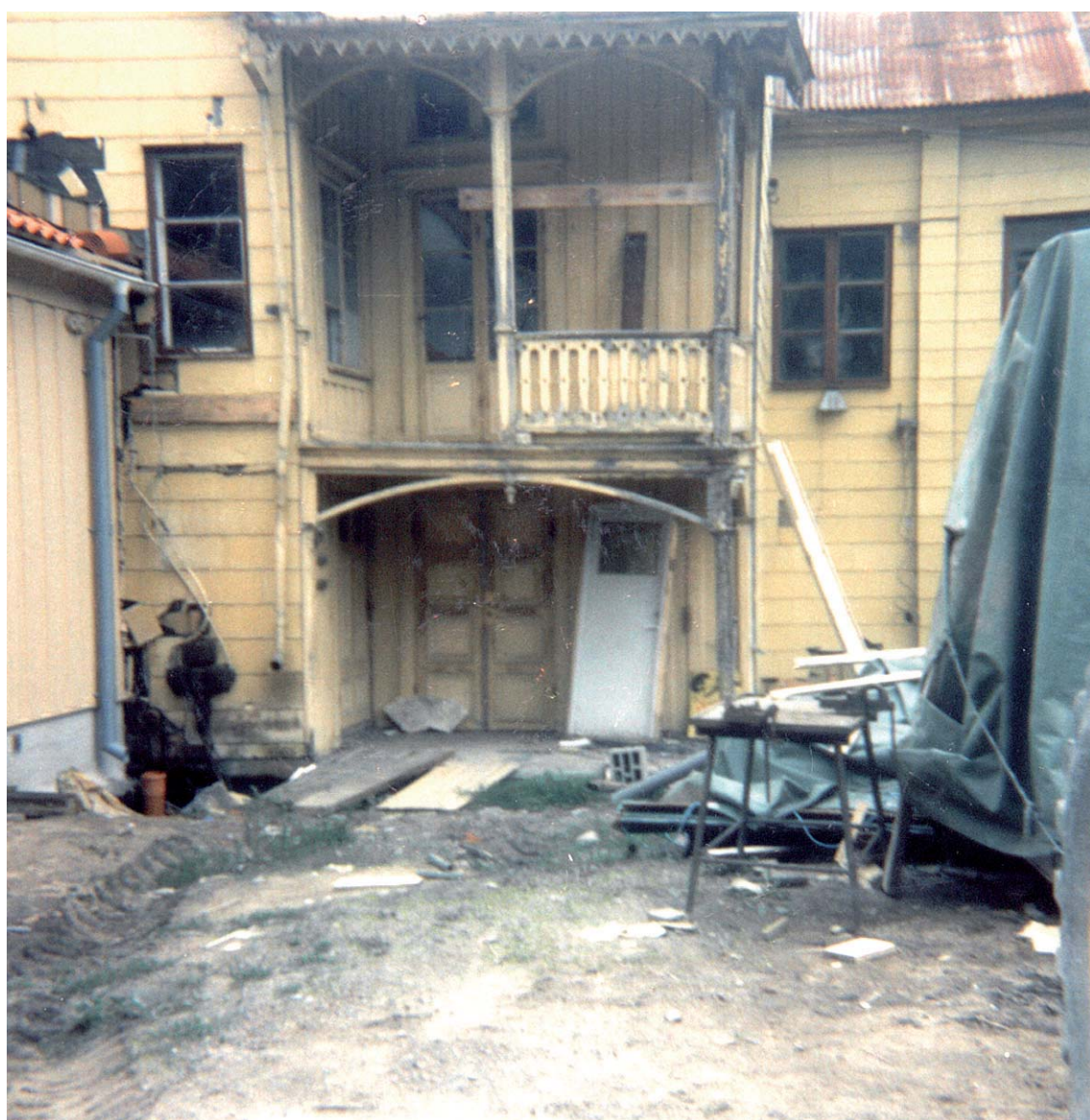
Gårdssidan av huset mot gatan före totalrenoveringen
