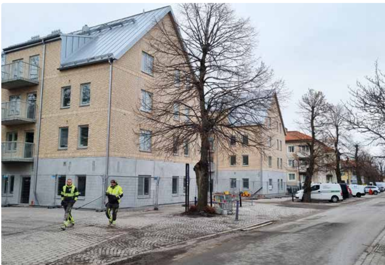
Bielkegatan med de två nya bostadshusen med tegelfasad.
