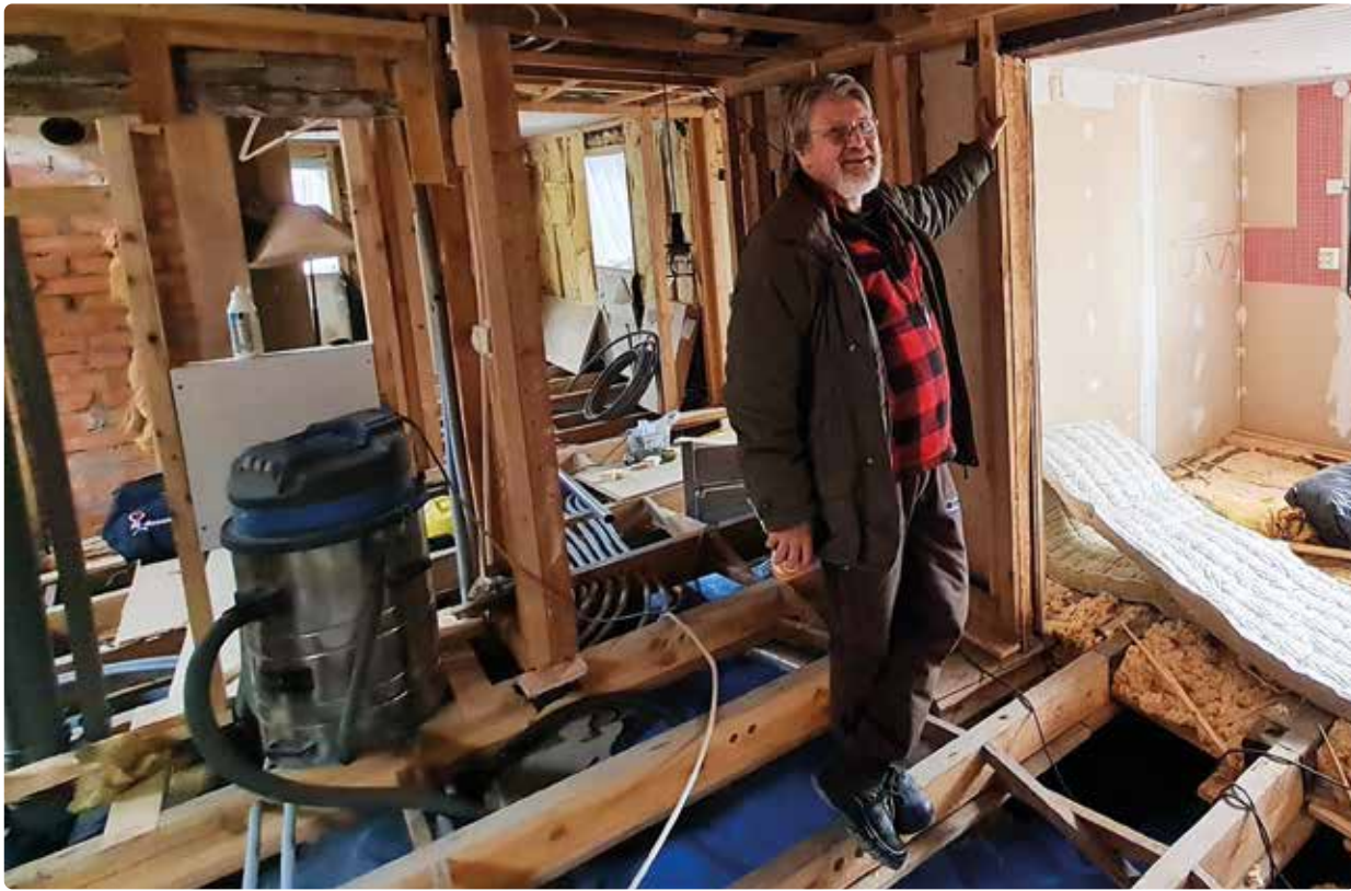
Hasse mitt i renoveringen.
