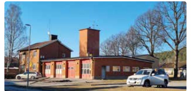
Gamla brandstationen - Söderköping Nortull 13 & 19 och del av Söderköping 2:84.
