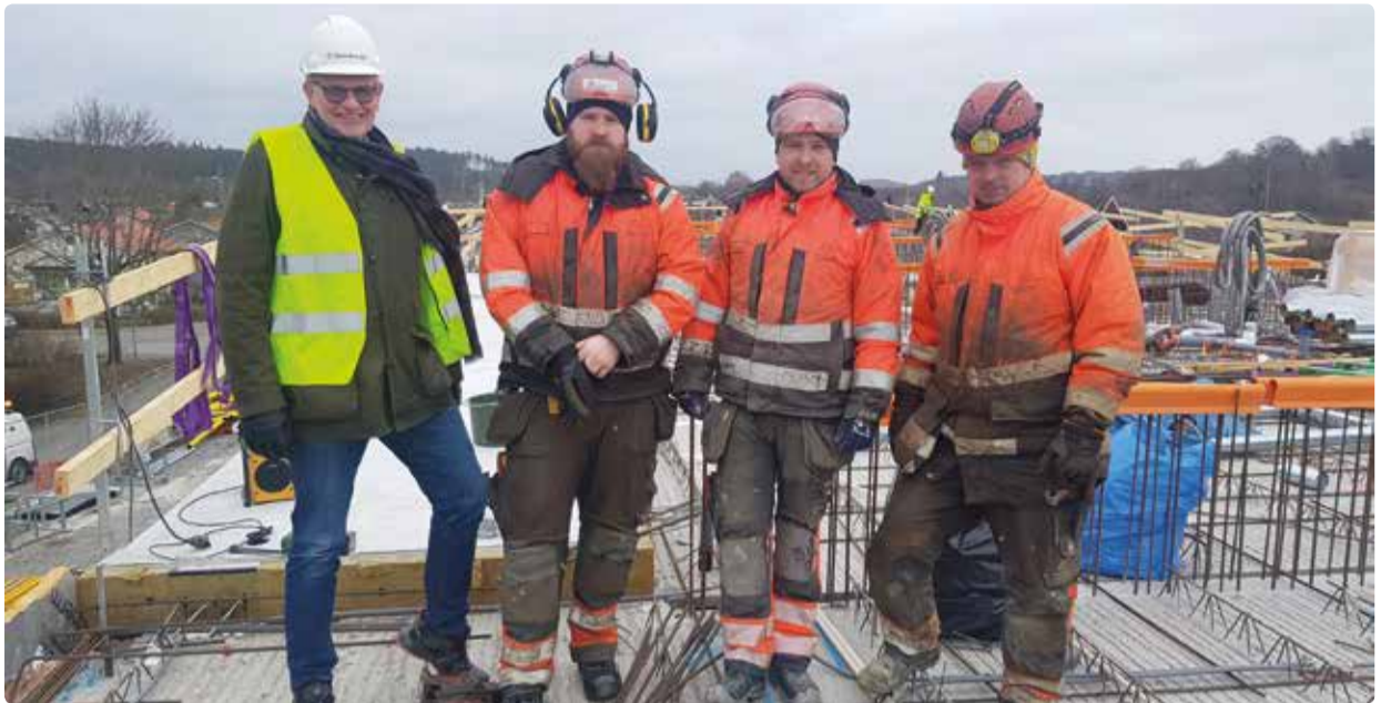
Kjell, Nicke, Robin och Robban vid byggarbetsplatsen.
