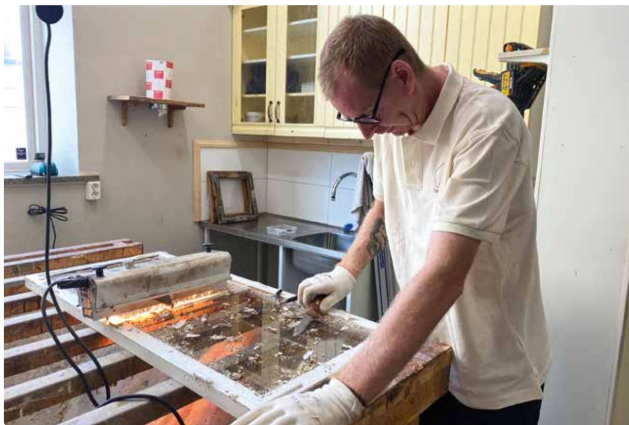
Gammalt kitt avlägsnas i ett av arbetsstegen.
