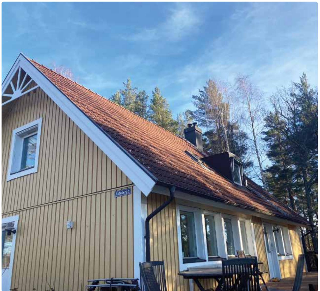
Västtaket på Sofieberg.
