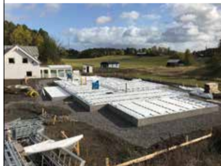
Grundläggning - platta på mark
