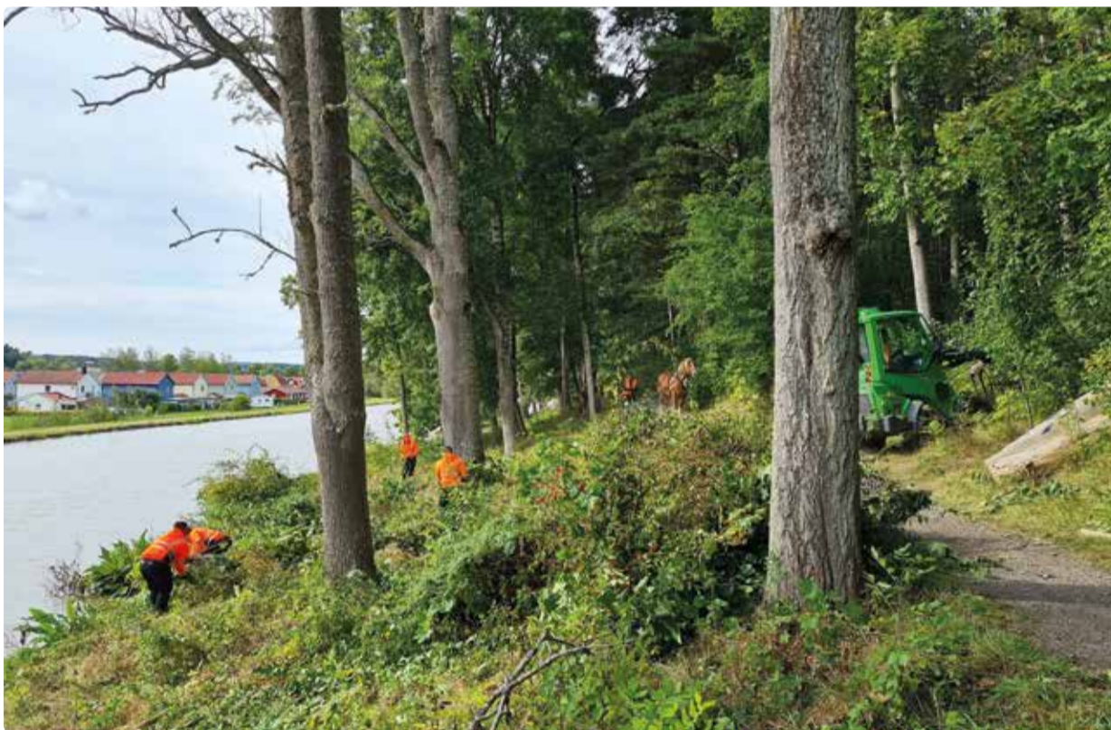
Arbetet är i full gång utmed kanalbanken i Söderköping.
