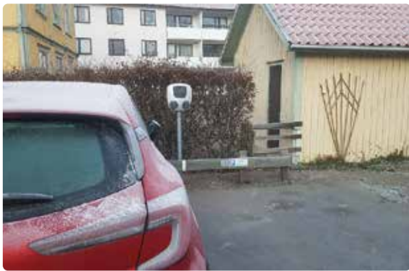
Parkering med nya laddstolpar.
