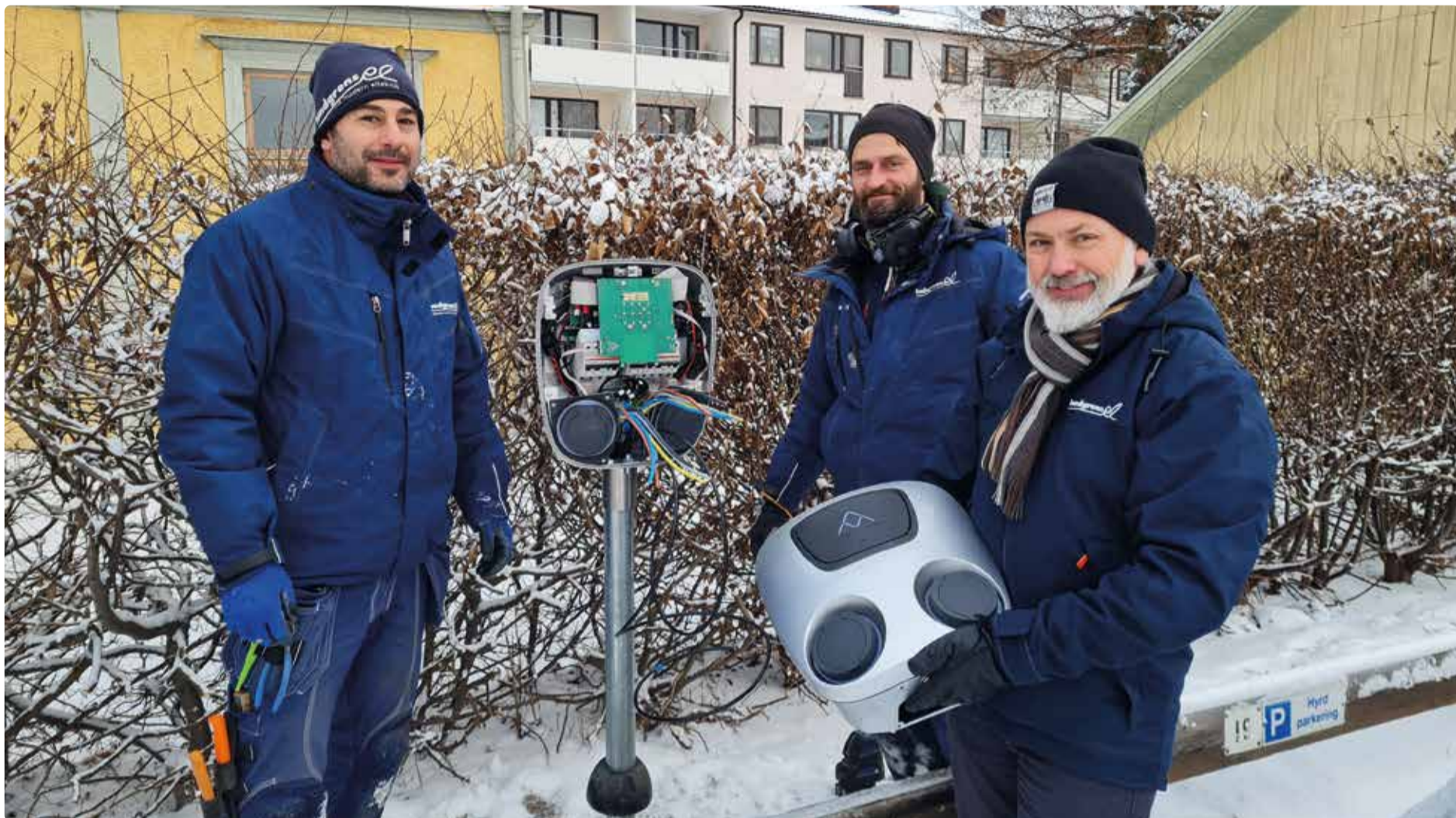
Lundgrens El utför installationen av laddstolparna.
