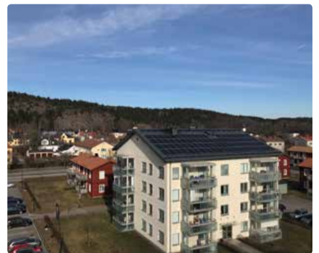
Det s.k. Svanenhuset med solcellsanläggningen.
