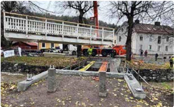
Den nya spången lyfts på plats.
