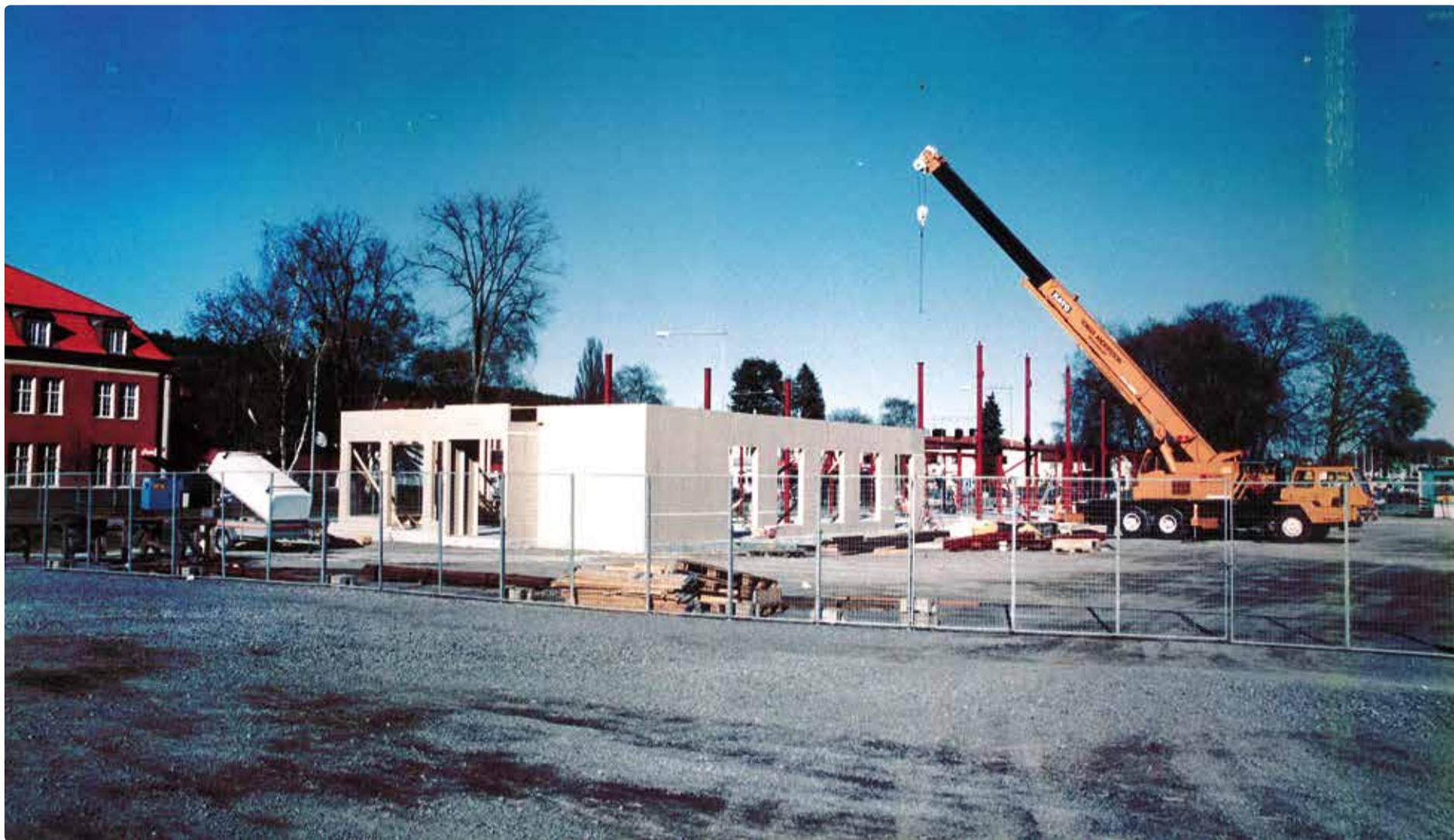
Efter en lång process kunde bygget av Stinsen påbörjas.
