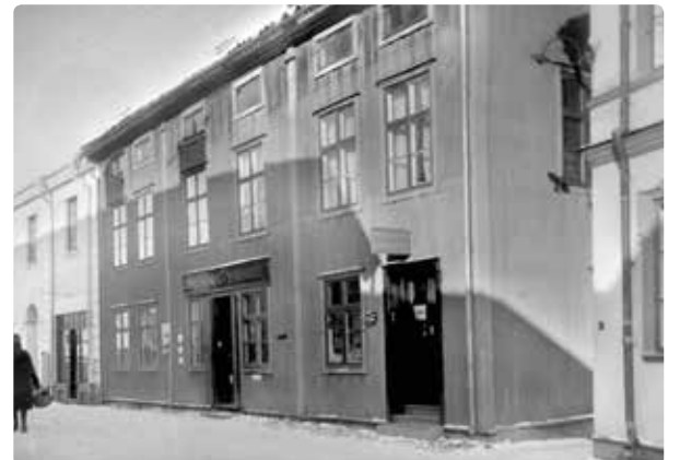
Bokhandelshuset med den lilla parfymaffären vars ingång nu är svår att upptäcka.
